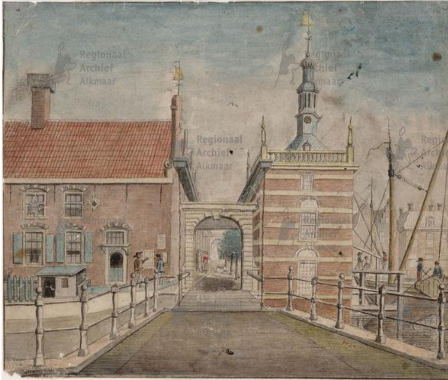
Gezicht op de Accijnstoren en in de Bierkade vanaf de brug over het Verdronkenoord; rechts de huizen van het Eiland. 1800
