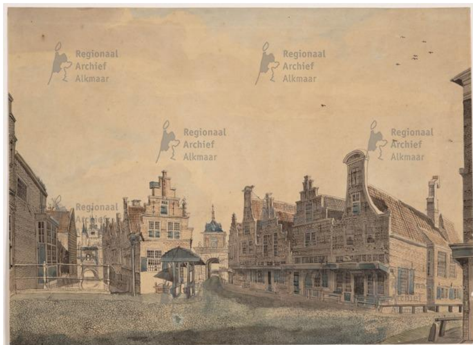
De Friese binnen- en buitenpoort gezien vanuit de Herenstraat, met een travalje op de hoek van de Dijk en de Herenstraat. 1809
