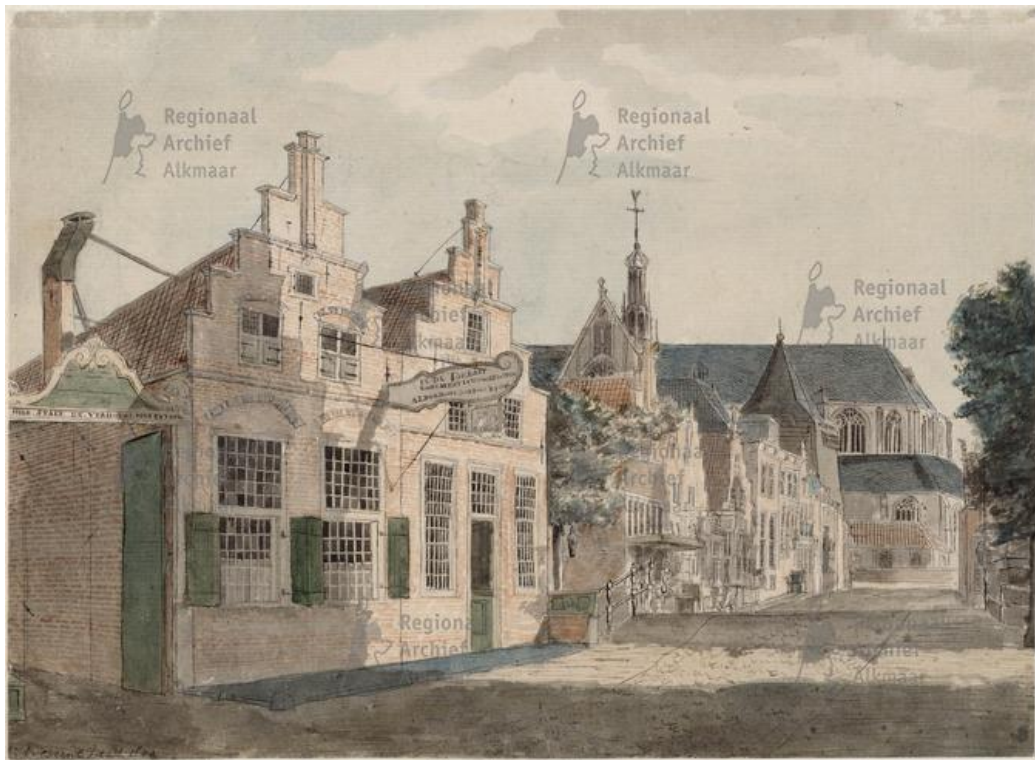
De Koorstraat Logement de Toelast, met de rijtuigstalling en brug over de Laat, klokkentoren en koor van de Grote Kerk. 1804
